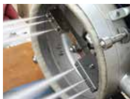
▲ 外壁塗膜除去装置噴射
