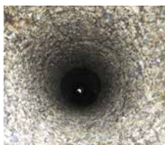
▲ 超高压水による除去洗浄後の煙突内
