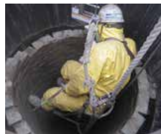
▲大型煙突解体作業の様子
