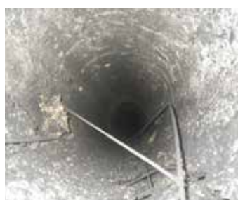
▲ 施工前の煙突内
