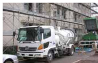
▲ 機材設置の様子 （超高压ポンプ車と吸引バキューム車）
