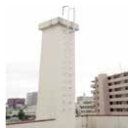
▲ 建物付随型煙突外観
